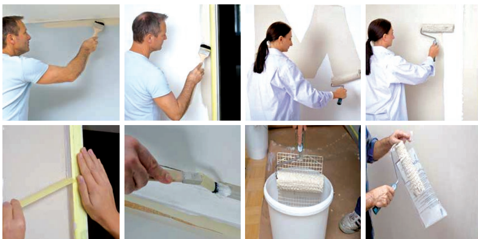
Slika 50 Postupak ličenja zida i čišćenje alata
