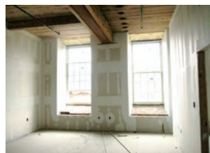
Slika 24 Izvođenje unutarnje izolacije stana bez izolacije prozorske klupčice ne preporučuje se
