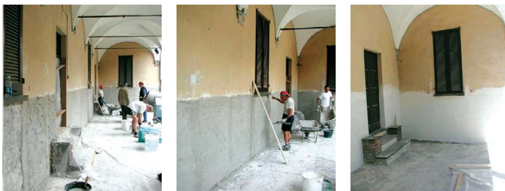
Slika 35 Primjer nanošenja temeljnog šprica, isušujuće te fine žbuke na postojeću zgradu
