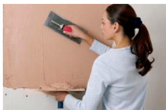
Slika 42 Gletanje gipskartonskih ploča
