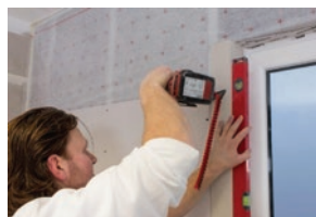
Ugradnja gipskartonskih ploča
