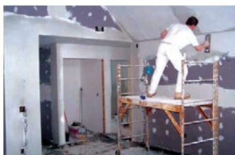
Slika 42 Gletanje gipskartonskih ploča
