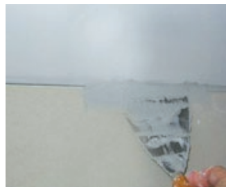
Obrada spojeva ploča sa zidom ili plafonom
