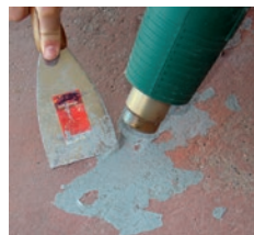
Slika 18 Električni fen za skidanje stare boje
