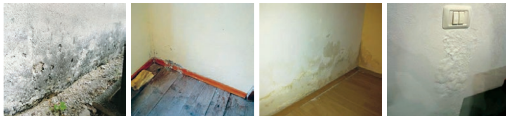
Slika 34 Primjeri oštećenja žbuke zbog kapilarnog dizanja vlage i oborinske vode, zbog loše ili nepostojeće hidroizolacije ili pak spriječenog isušivanja ugradbene vlage
