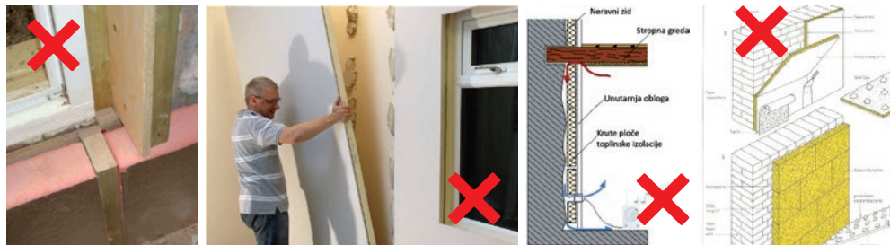
Slika 29 Prikaz loše ugradnje sustava unutarnje toplinske izolacije
