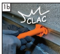
Ugradnja pričvrsnice u metalnu vodilicu
