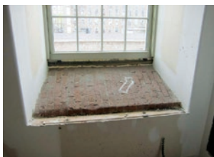
Slika 24 Izvođenje unutarnje izolacije stana bez izolacije prozorske klupčice ne preporučuje se
