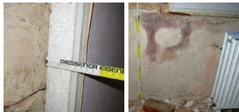
Slika 27 Razvoj gljivica nakon skidanja sloja unutarnje toplinske izolacije
