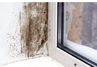
Slika 25 Rast gljivica i plijesni zbog kondenzacije na špaleti prozora
