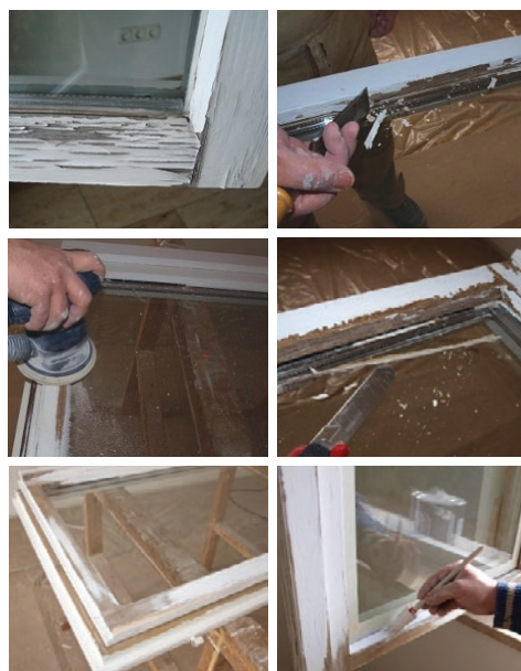
Slika 39 Primjer starog naliča, skidanje brtve sa stakala i brušenje starog naliča s drvene stolarije, zaglađeno prozorsko krilo i nanošenje premaza za drvo
