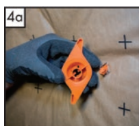
Pričvršćenje toplinske izolacije pomoću odgovarajuće spojnice (kapice)
