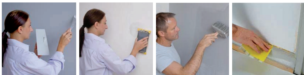
Slika 48 Priprema podloge
