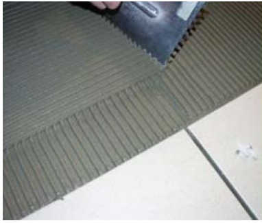
Obrada ljepila nazubljenim gleterom
